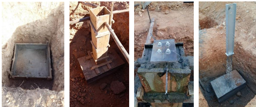
รูปภาพ 55 การก่อสร้างฐานรากโดยการหล่อตอม่อ
