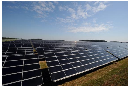
รูปภาพ 69 ระบบผลิตไฟฟ้าพลังงานแสงอาทิตย์ที่ติดตั้งบนพื้นดิน
