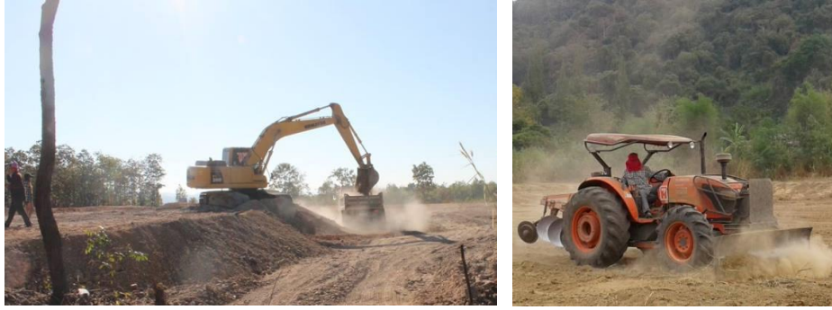
รูปภาพ 54 การเตรียมพื้นที่สำหรับติดตั้งแผงเซลล์แสงอาทิตย์
