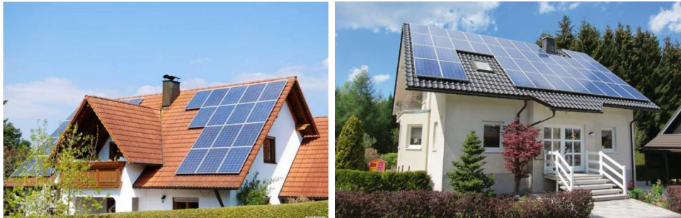
รูปภาพ 70 ระบบผลิตไฟฟ้าพลังงานแสงอาทิตย์ที่ติดตั้งบนหลังคา
