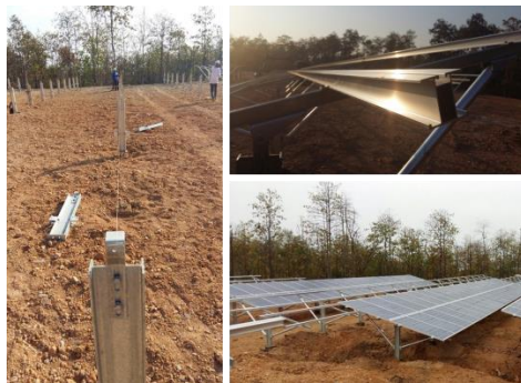
รูปภาพ 57 การติดตั้งโครงสร้างรองรับแผงเซลล์แสงอาทิตย์
