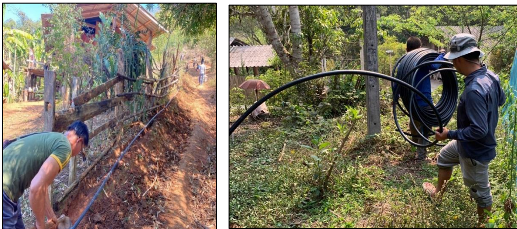
ภาพที่ 5 การเดินท่อส่งน้ำ จากแหล่งน้ำดิบไปยังถังเก็บน้ำ
