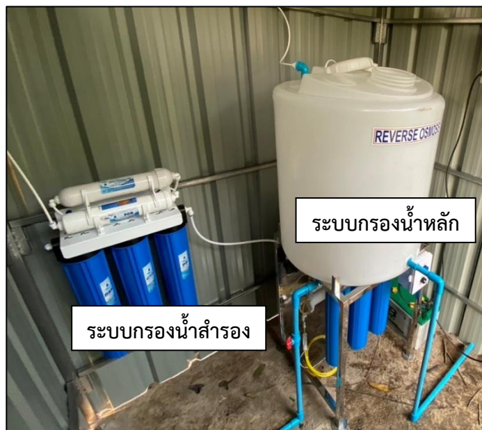
ภาพที่ 7 ระบบการกรองน้ำดื่ม ณ หอย่อมบ้านนาปูทอง ต.กุดช้าง
