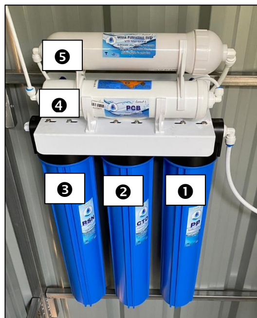
ภาพที่ 9 ระบบการกรองสำรอง ขนาดกำลังการผลิต 400 ลิตร/วัน
