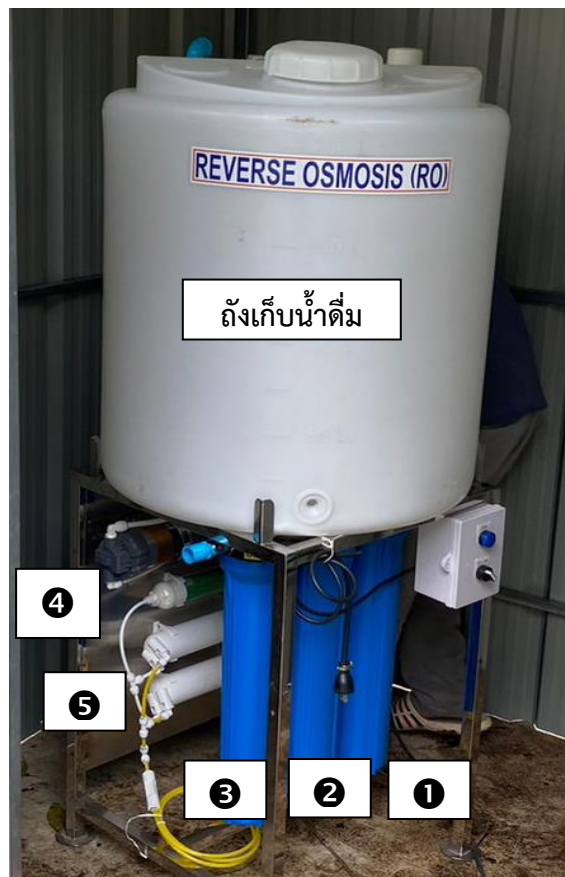
ภาพที่ 8 ระบบการกรองระบบหลักด้วยระบบรีเวอร์สออสโมซิส ขนาดกำลังการผลิต 1,000 ลิตร/วัน
