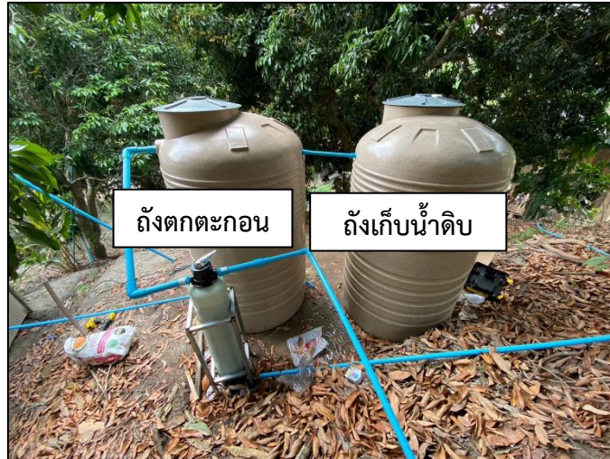
ภาพที่ 6 ถังเก็บน้ำดิบ และถังตกตะกอน ด้วยถังพลาสติก PE ขนาด 1,000 ลิตร
