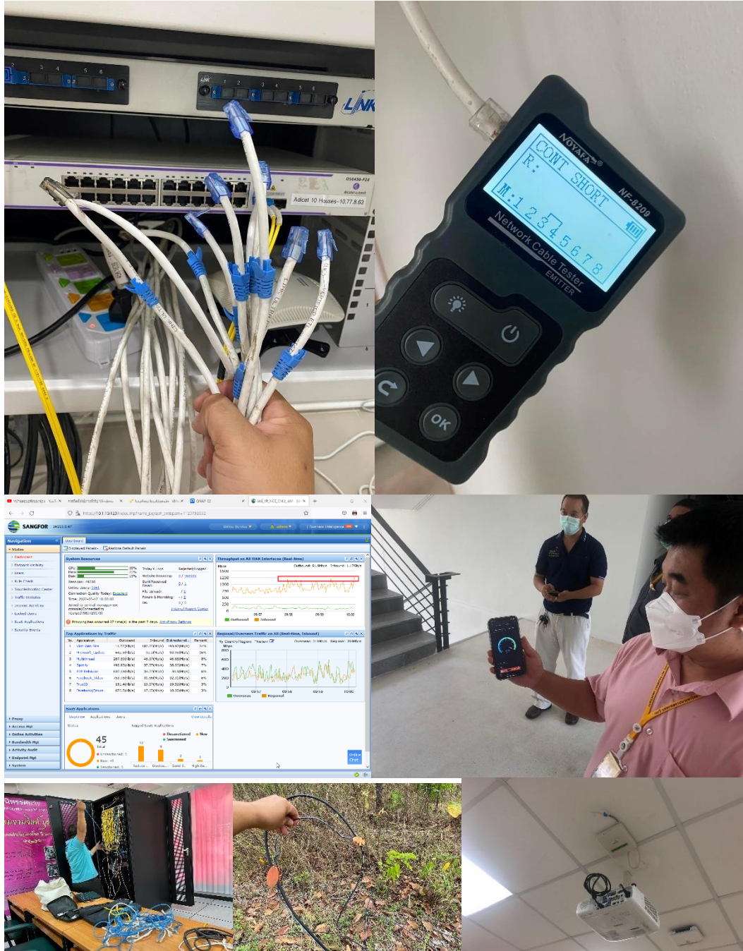
ภาพที่ 38 การสำรวจและติดตั้งอุปกรณ์เครือข่ายไร้สาย
